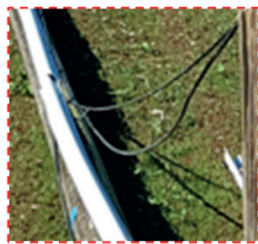
Plusieurs câbles (cuivre et fibre) → infrastructure partagée
