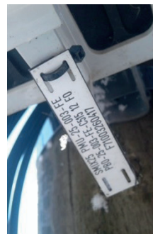
Identification d'un câble posé par le Syndicat mixte au niveau d'un boîtier (étiquette blanche)
