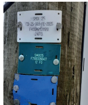
Réseau Syndicat mixte sur poteau Orange déployé en 2 temps. Avant 2018 (étiquette verte) puis après 2018 (étiquette blanche). Étiquette bleue (identification Orange)
