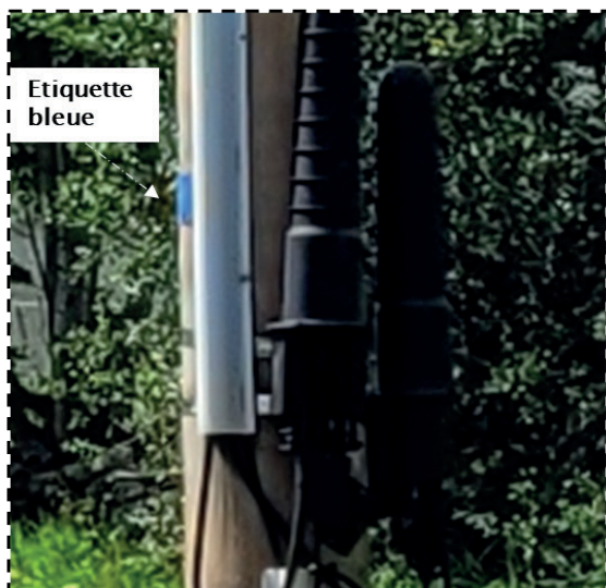
Equipements cuivre et poteaux réinstallés
